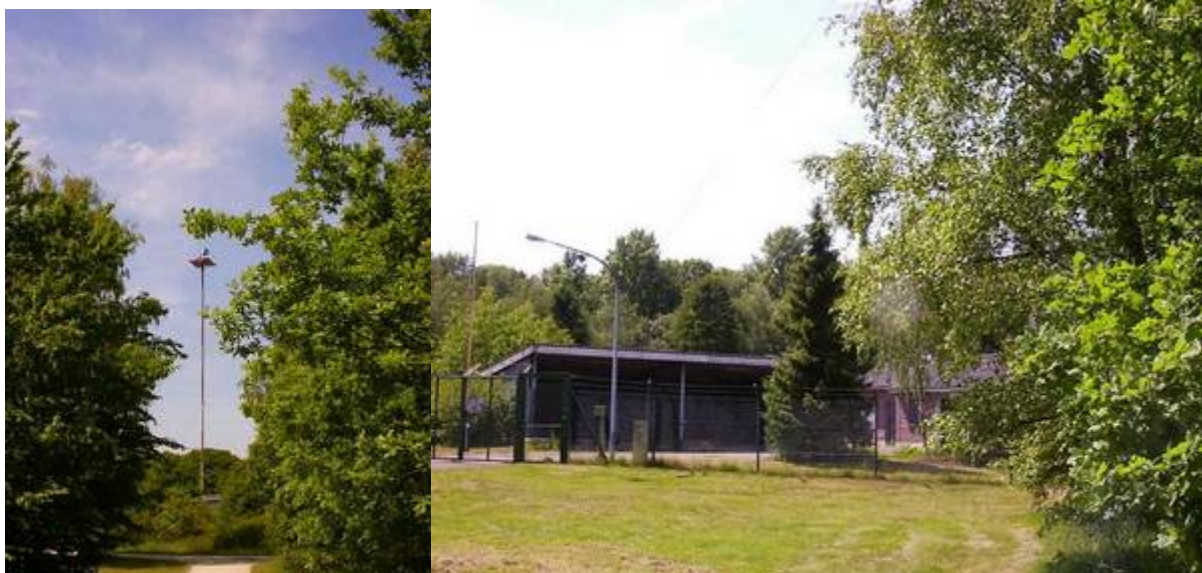
Der Fernmeldemast im Stadtwald mit einem kleinen Gebäude für Personal und Betrieb. Bis zum Frühjahr 2012 markierte der Mast noch die lange bescheidene militärische Präsenz der Bundeswehr in Bocholt.
