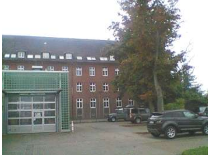
Noch einmal der alte Block der Nachschubkompanie von hinten aus Richtung „Henri-Dunant-Str.“. Das Polizeipräsidium ist durch einen Zaun vom heute gewerblich genutzten Gebiet des alten technischen Bereichs abgegrenzt. Wo jetzt dieses Autohaus steht, waren 1972-73 die MAN Fünftonner“ des Transportzuges 100 t und der Fahrschule abgestellt. (Foto 2013)
